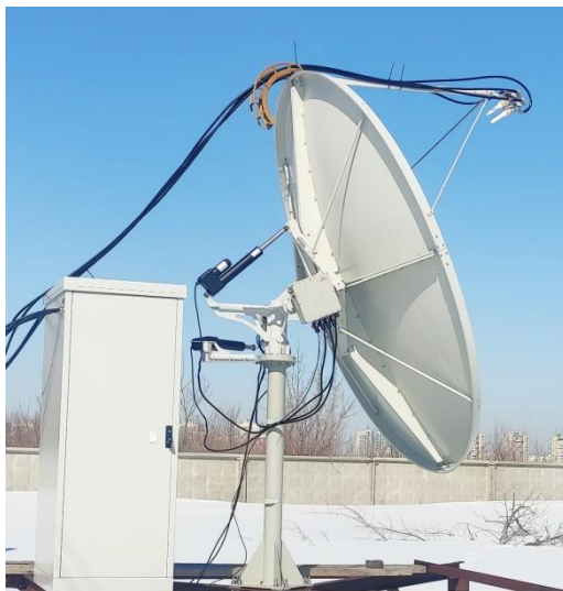
Рисунок 1 – Стационарная станция тропосферной радиосвязи ЦСТР-С, установленная в пос. Придорожный
